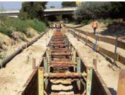
Kanal für die Abwasserdruckleitung am neuen Nordufer
